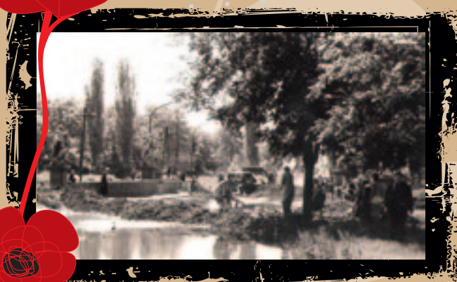
Védekezés a Gombás patakánál az 1965-ös árvíz idején
